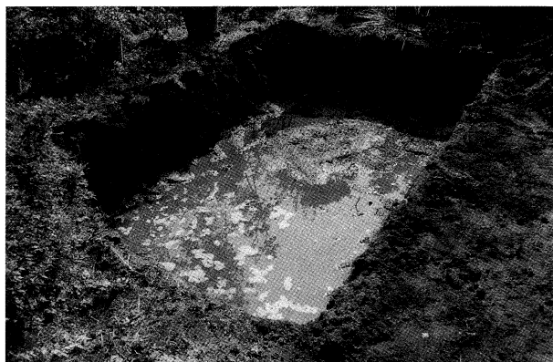
2. T1トレンチ掘削状況
