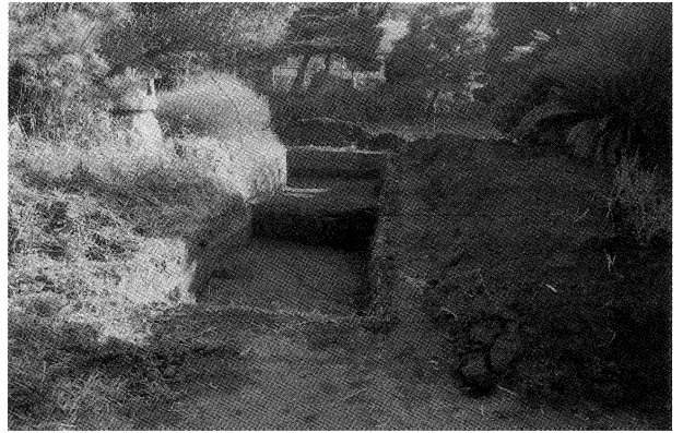
2. トレンチ掘削状況
