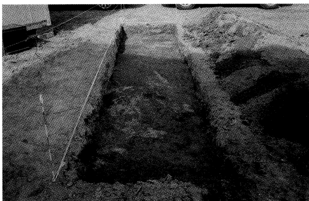
5. 3 トレンチ掘削状況
