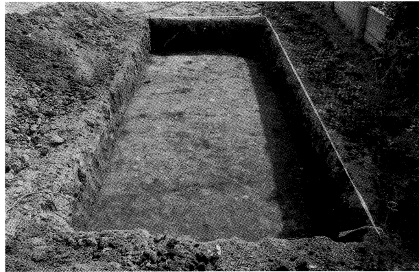
4. 2 トレンチ掘削状況
