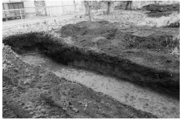
(2) 2号中央 T 完掘状況
