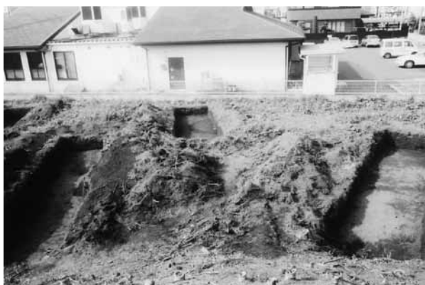
(5) トレンチ完掘状況-1-
