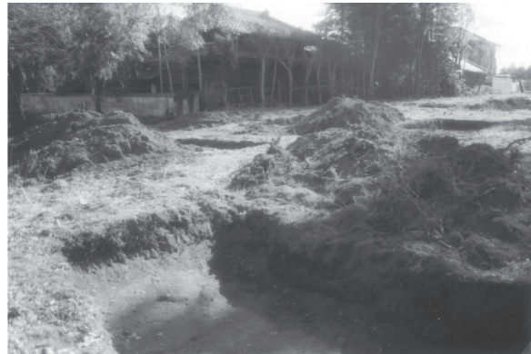
逆水遺跡 j 地点 トレンチ状況
