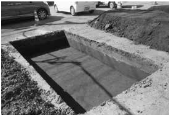
5. 6 トレンチ確認面検出状況
