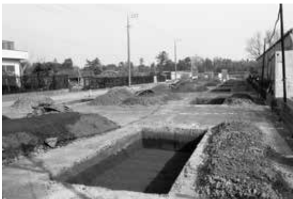
7. トレンチ掘削状況
