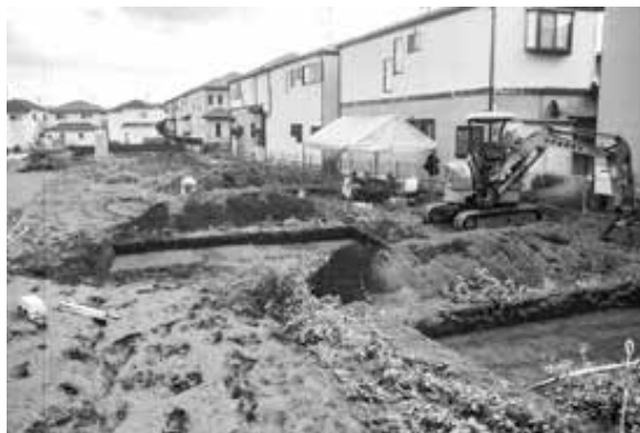
1. トレンチ掘削状況
