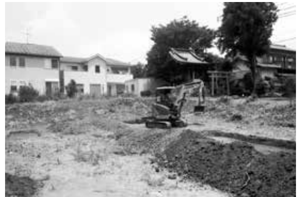
2. 表土掘削作業
