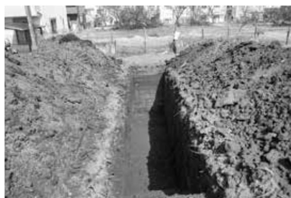
4. 2トレンチ確認面検出状況
