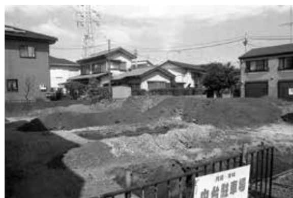
6. トレンチ完掘状況全景
