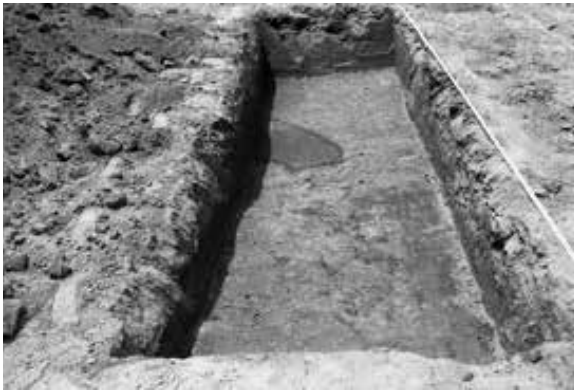
3. 2トレンチ確認面検出状況
