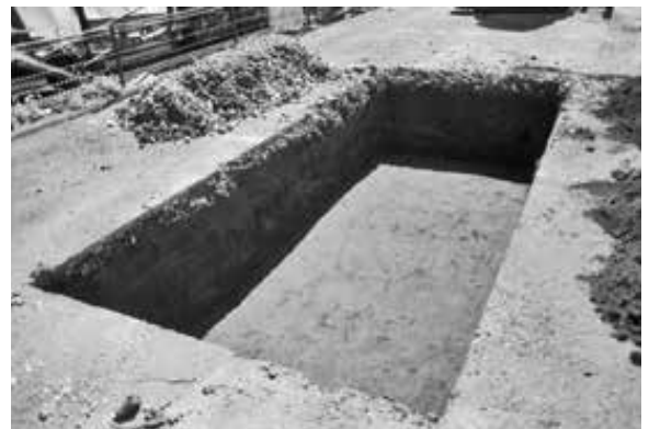
4. 2 トレンチ確認面検出状況
