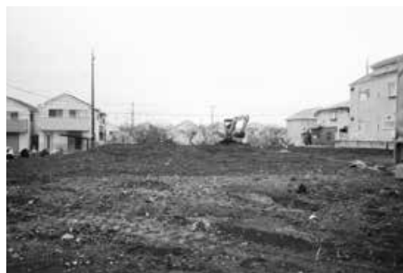
8. 埋め戻し作業
