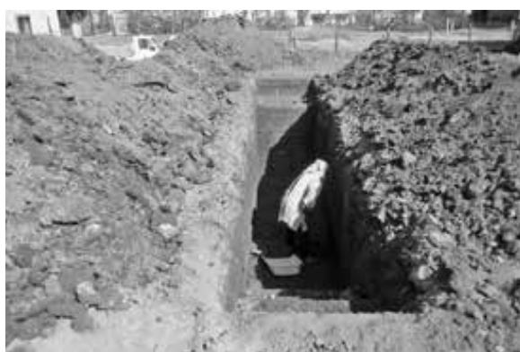
3. トレンチ清掃作業
