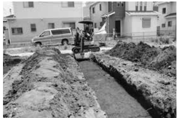
2. トレンチ掘削作業
