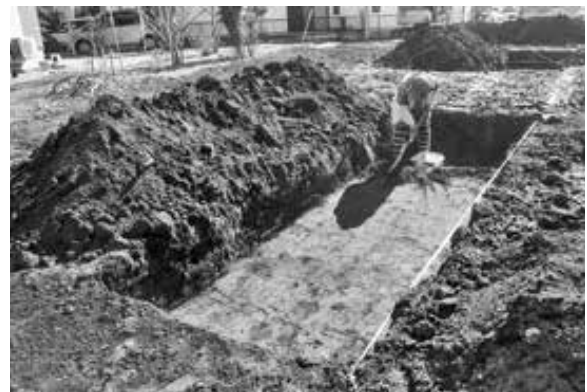
2. トレンチ清掃作業
