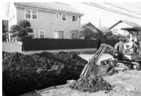
2. トレンチ掘削作業
