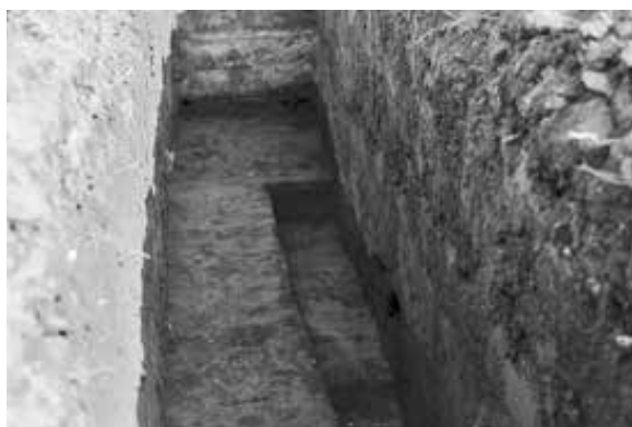
7. サブトレンチ掘削状況
