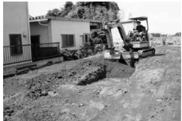
6. 埋め戻し作業
