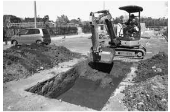
2. トレンチ掘削作業
