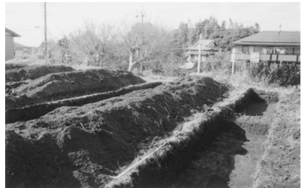
2. トレンチ掘削状況
