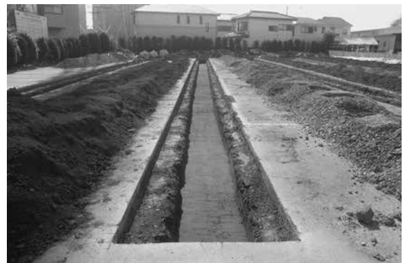
4. 4トレンチ確認面検出状況
