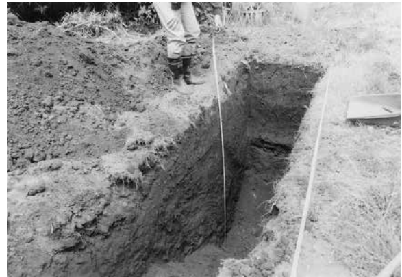
4. 2トレンチ掘削状況
