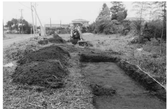
2. トレンチ掘削状況
