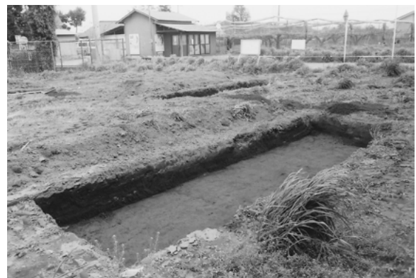
4. トレンチ掘削状況
