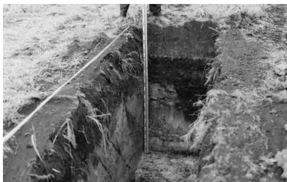
3. トレンチ掘削状況
