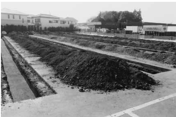
7. トレンチ完掘状況
