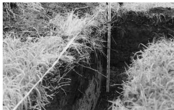
4. トレンチ掘削状況
