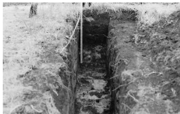
4. トレンチ掘削状況
