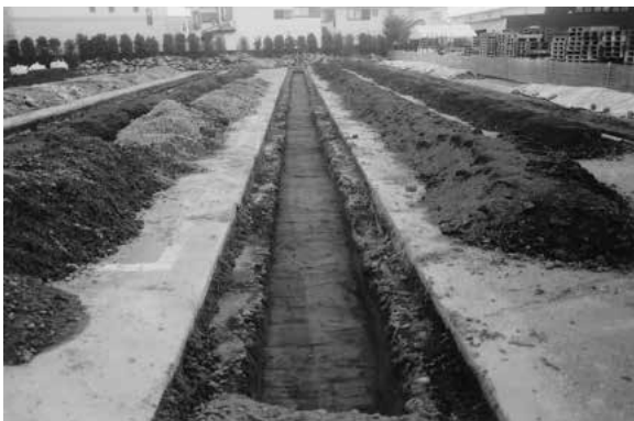
3. 2トレンチ確認面検出状況
