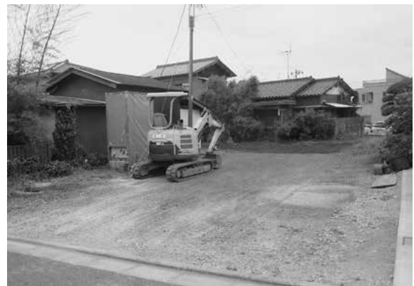
6. 埋め戻し完了状況
