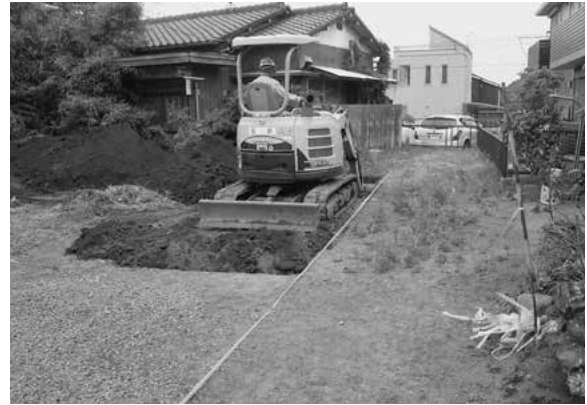
2. トレンチ掘削状況
