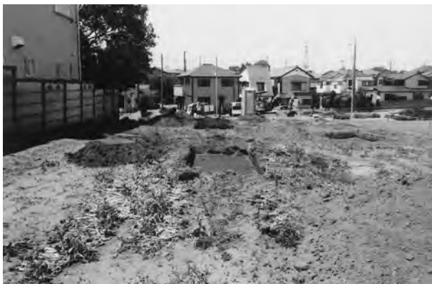
3. トレンチ掘削状況
