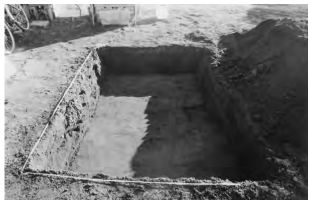
4. Cトレンチ掘削状況
