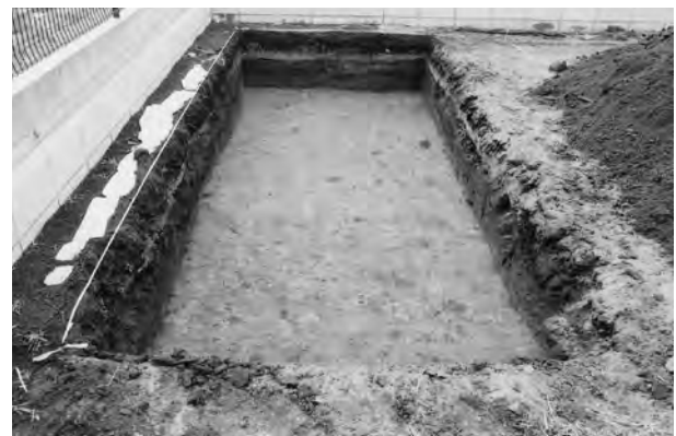
4. Aトレンチ掘削状況
