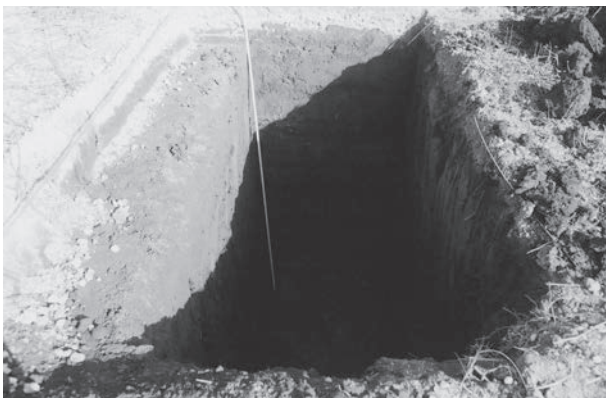
(3) A-2G掘削状況
