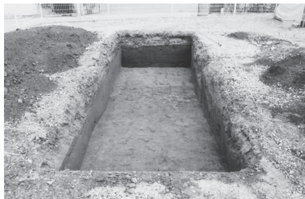
(2) AT掘削状況
