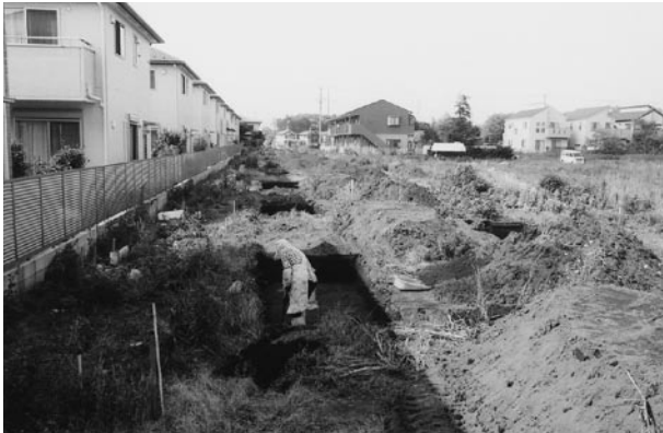
(1) 西側地点調査状況
