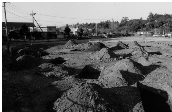
(2) トレンチ掘削状況
