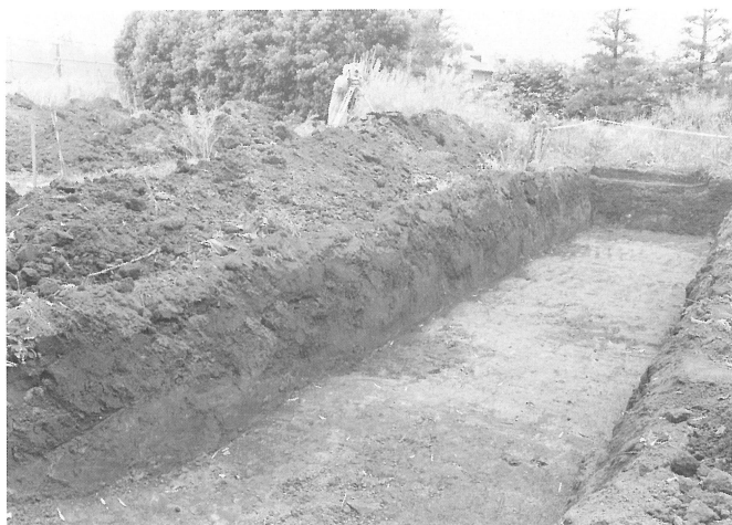
(2)トレンチ掘り下げ状況
