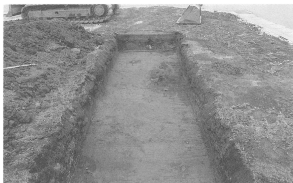
(1) トレンチ掘削状況
