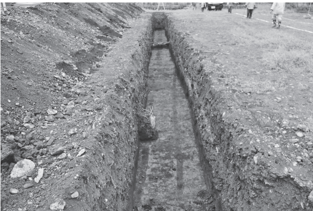
浄禅寺跡遺跡第 43 地点トレンチ 4
