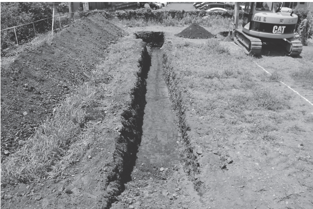
浄禅寺跡遺跡第 43 地点トレンチ 1
