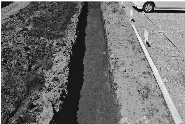
長宮遺跡第 53 地点トレンチ 1
