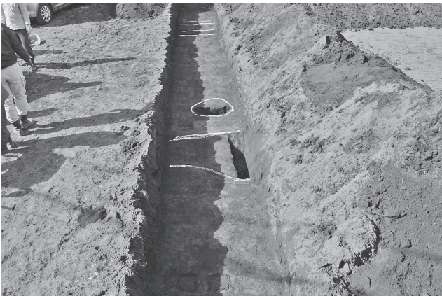
長宮遺跡第 57 地点トレンチ 2
