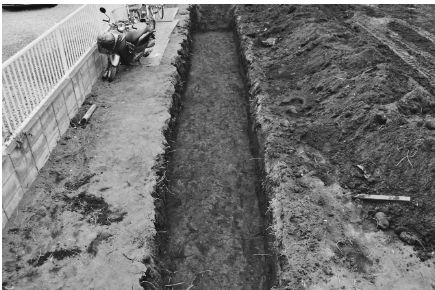
長宮遺跡第 53 地点トレンチ 3
