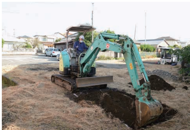
6. 2Tr 重機掘削の様子 (南西から)
