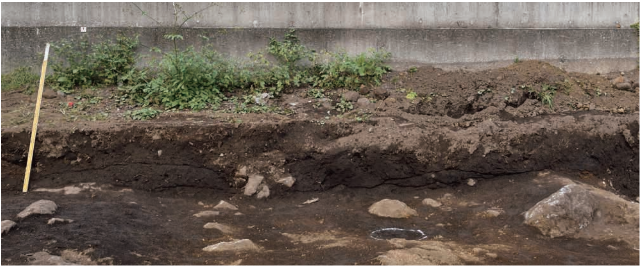
1. 1工区北壁（南から）
