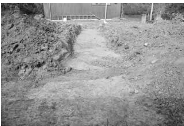
土井城跡（防火水槽）
