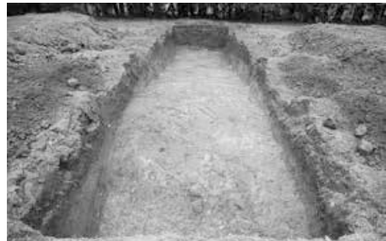
下毛1区3TR完掘状況 (北から)
