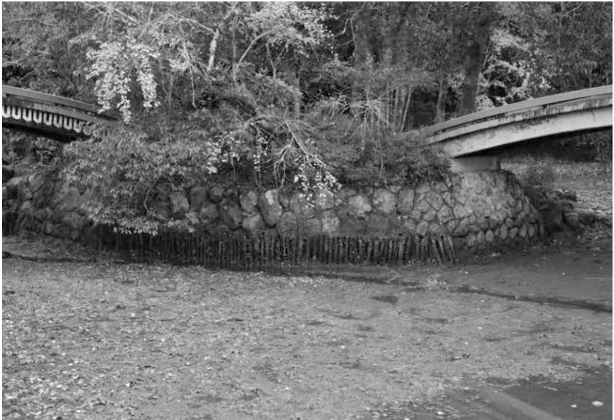
史跡宇佐神宮境内 菱形池中島 護岸検出状況（西から）
