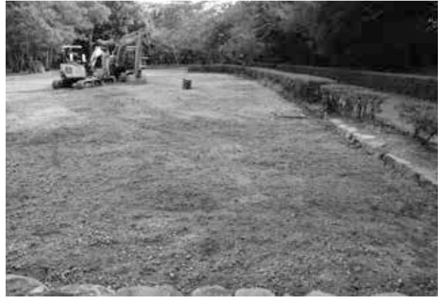
参集殿西側通路 完掘状況（北から）
