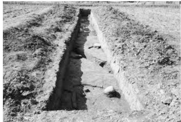
下原遺跡 3TR 完掘状況（東から）
