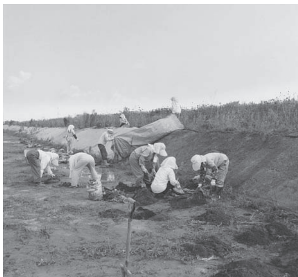
養生工事準備作業風景 NW→SE
