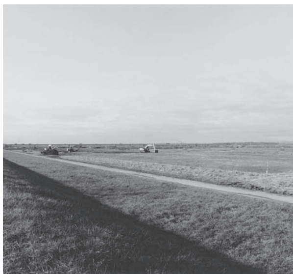
養生工事状況 SE→NW
