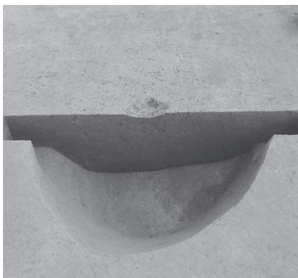
P-220断面 SW→NE
