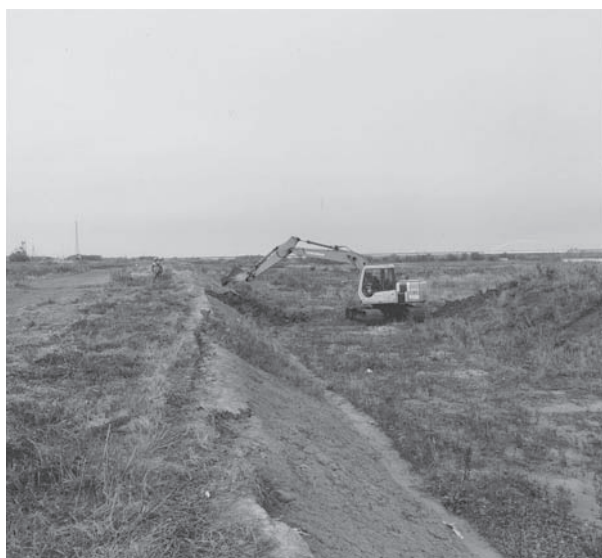
養生工事状況 SE→NW
