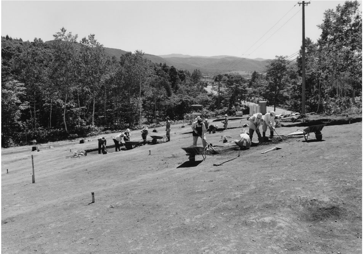
1 日の出2遺跡A地区調査状況（東から）
