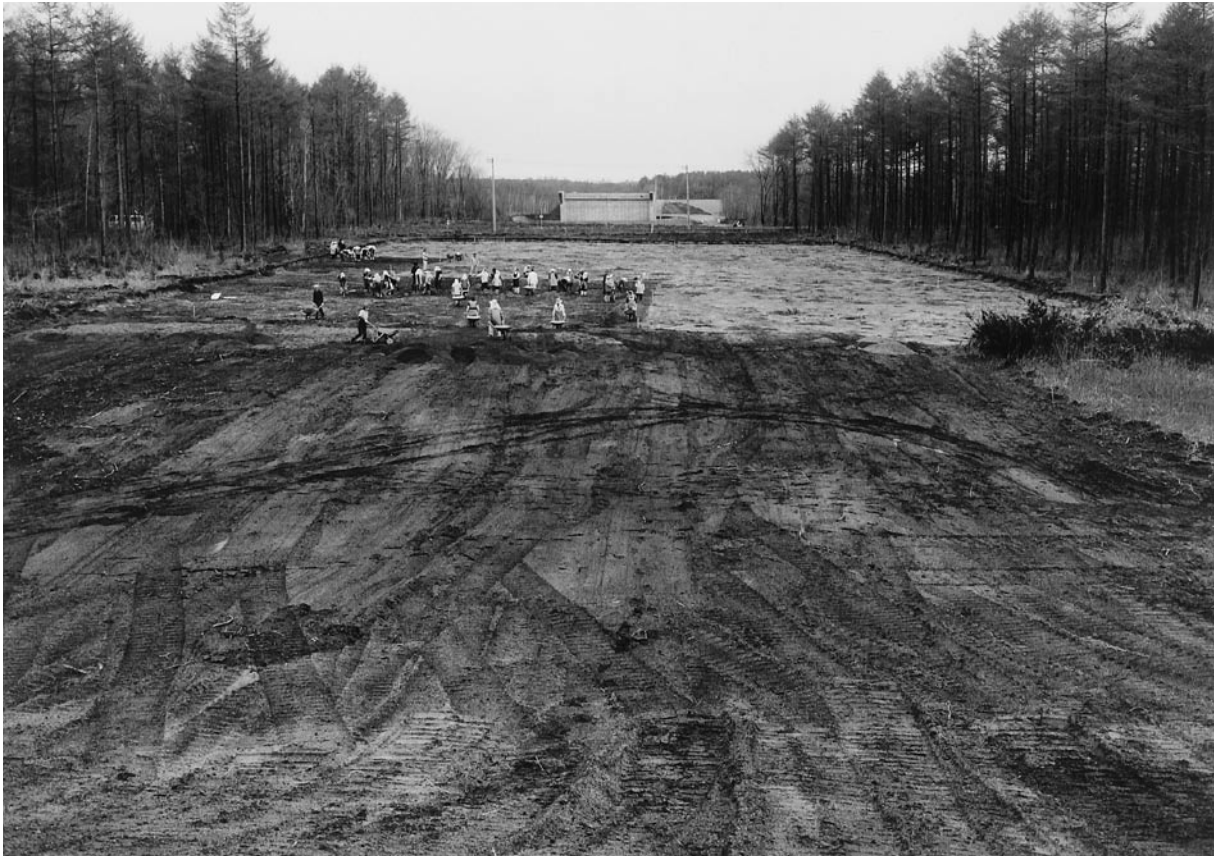
1 火山灰除去作業(平成16年度調査区) N→
