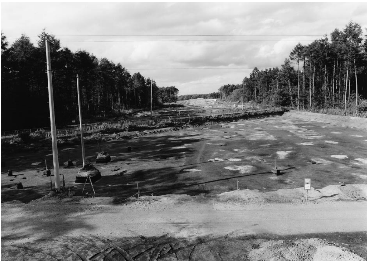
1 平成16年度調査区完掘 S→
