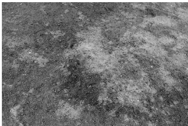
1 UF-38検出状況 NE→
