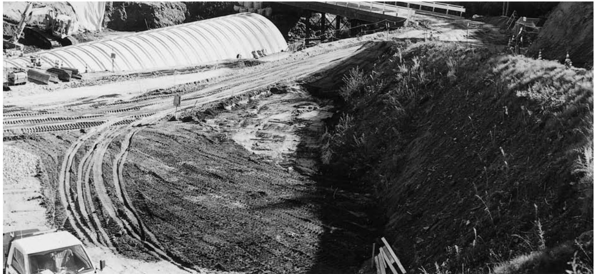
平成16年度 表土除去後状況
