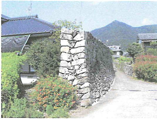
写真 3-1 棚底地区の防風石垣
