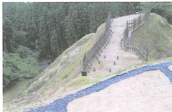
写真 12 曲輪面雨水誘導施設の参考例 (堅志田城跡)
