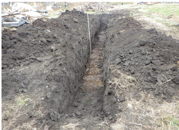
写真44 1トレンチ全景（南西から）
