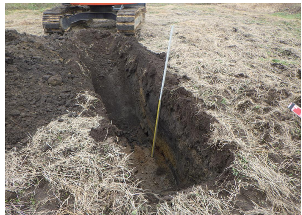
写真45 2トレンチ全景（南西から）
