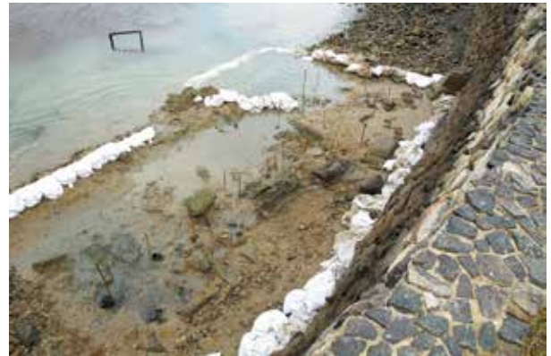
写真6 砂の侵入を軽減するため調査区を土のうで囲む
