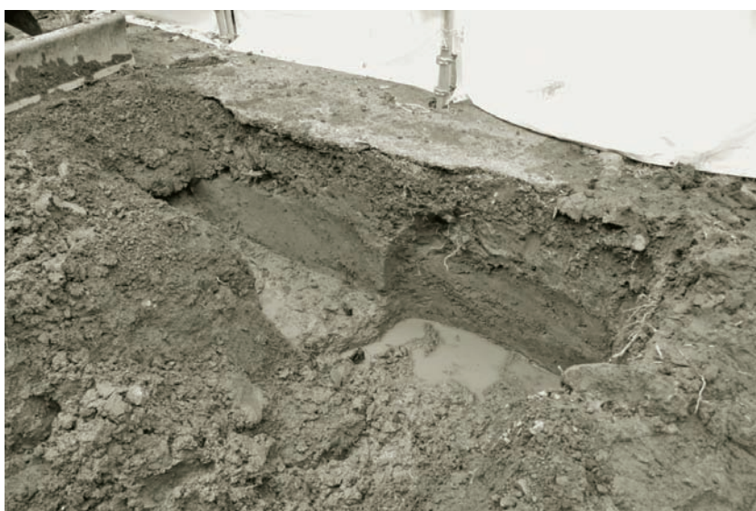
Aトレンチ (南東から)
