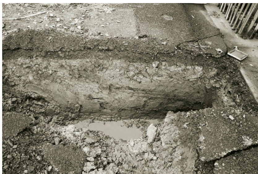
B トレンチ (東から)
