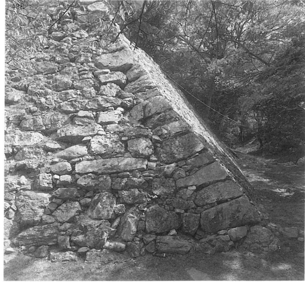
2. 北面石垣出隅部下半(北から)
