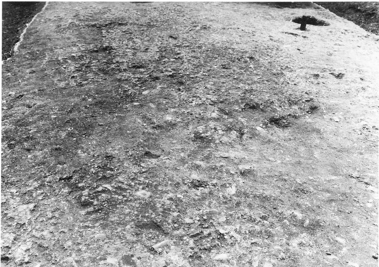
2. 道路遺構の舗装状態(南から)
