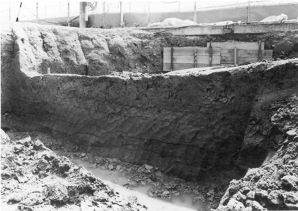
2. 断ち割り状況(北西から)
