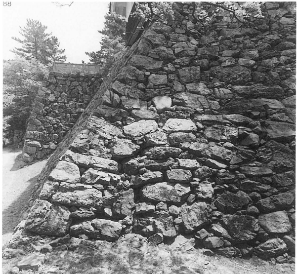
4. 西面石垣出隅部(西から)
