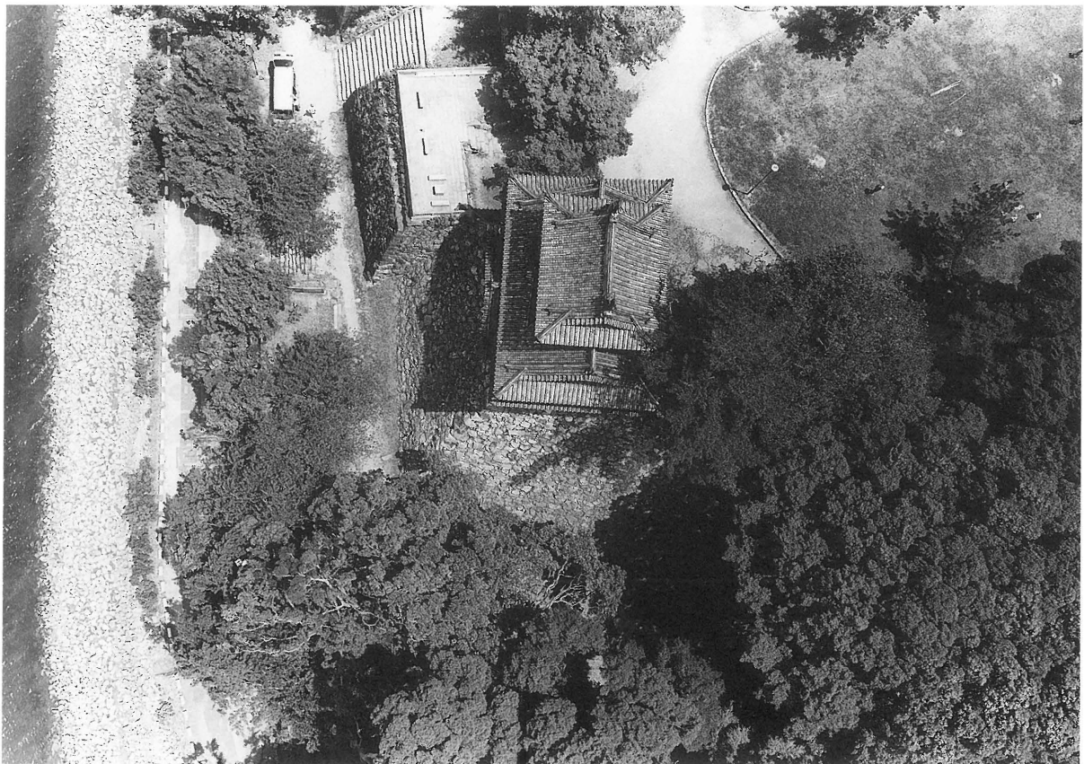
2. 鉄櫓下石垣全景二(西から)
