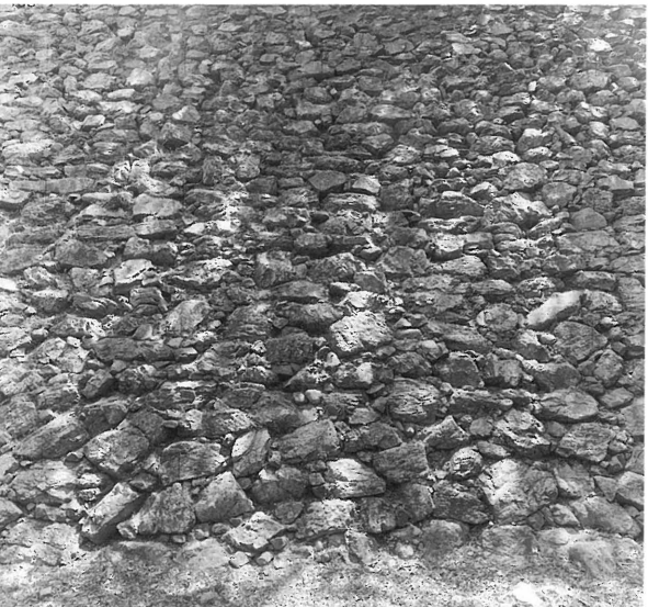
5. 西面石垣中央(西から)
