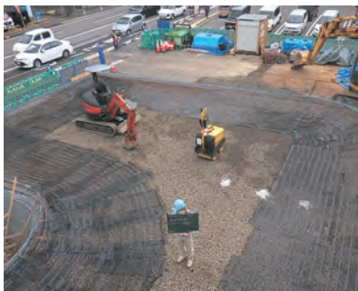
ジオグリッド設置状況
