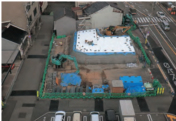
軽量盛土工 (EPS) 設置状況
