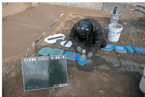
石垣の変遷表示施工状況
