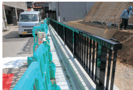
立入禁止柵施工完了
