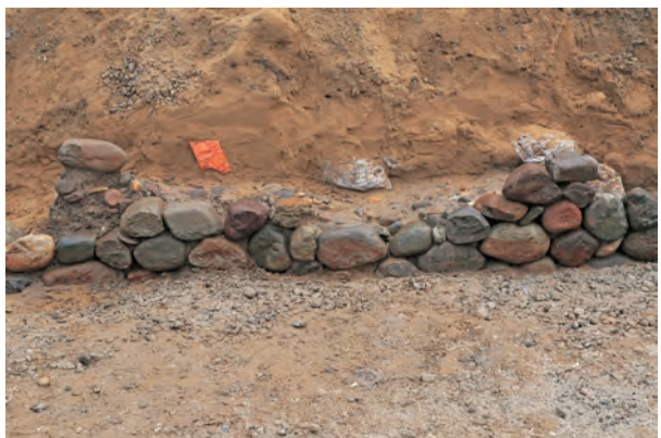
石垣 4 B 部分撤去状況
