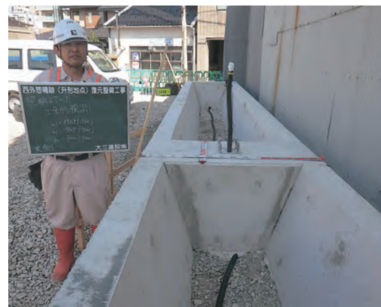
植樹枠設置状況
