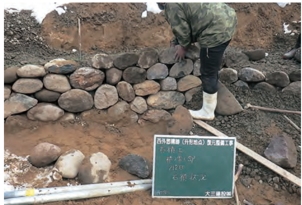
石垣積み増し状況
