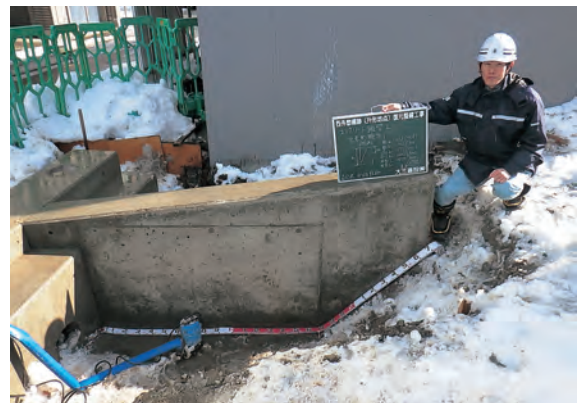
コンクリート擁壁（下流側）設置状況
