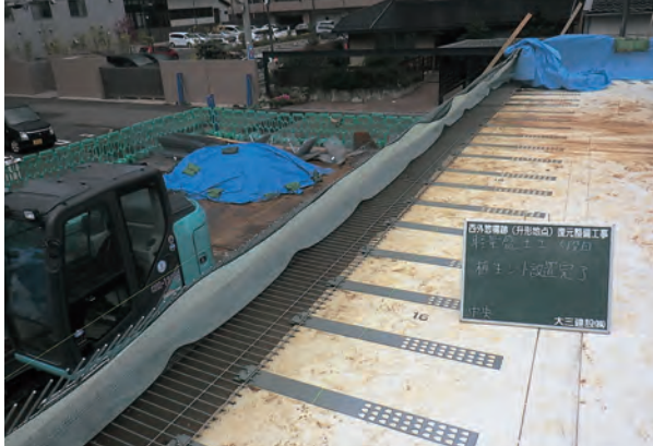
植生シート設置状況
