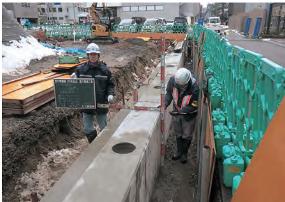
コンクリート擁壁（北側）設置状況
