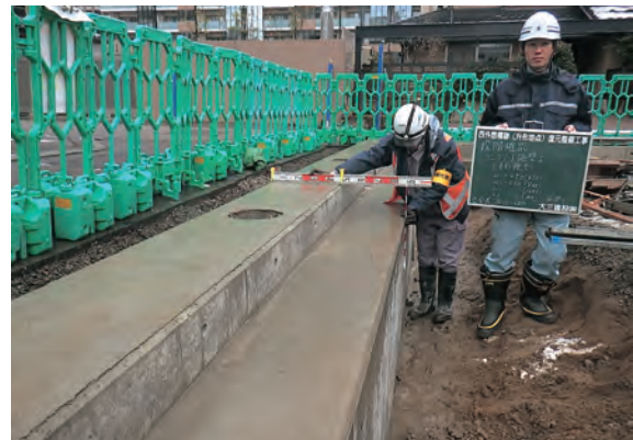
コンクリート擁壁（西側）設置状況
