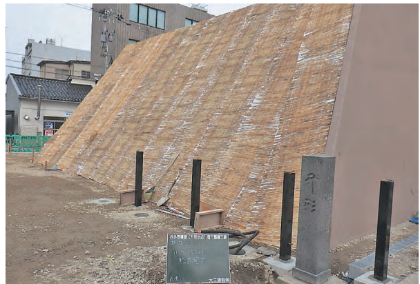
土居法面コモ設置状況
