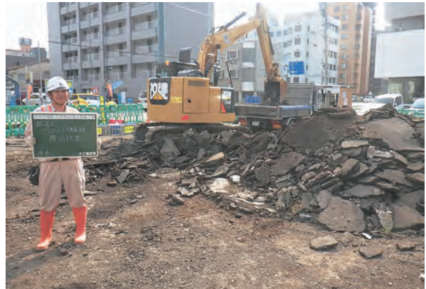
アスファルト舗装撤去
