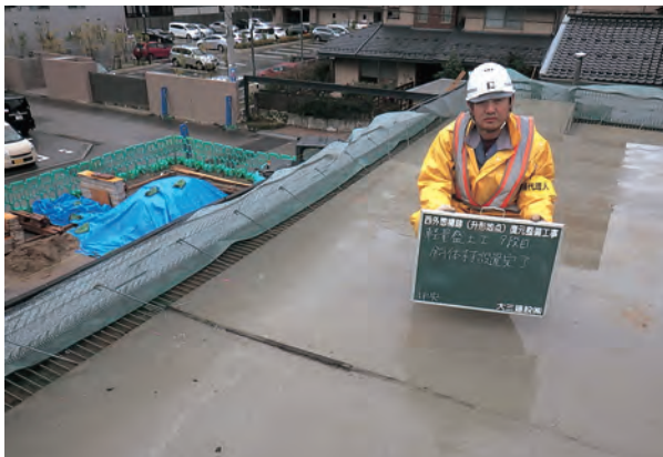
床板コンクリート設置完了
