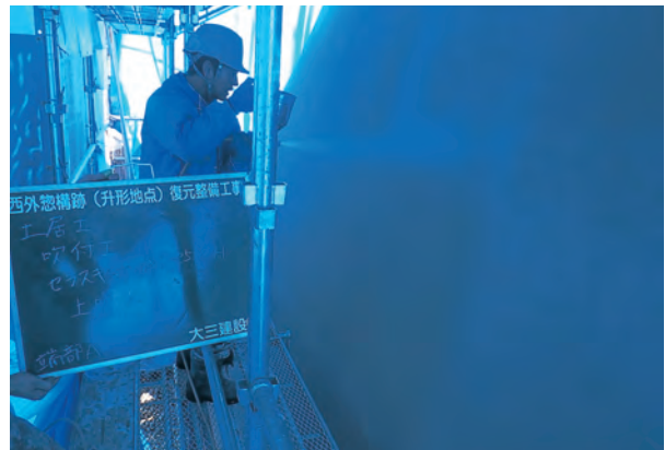
土居端部吹付
