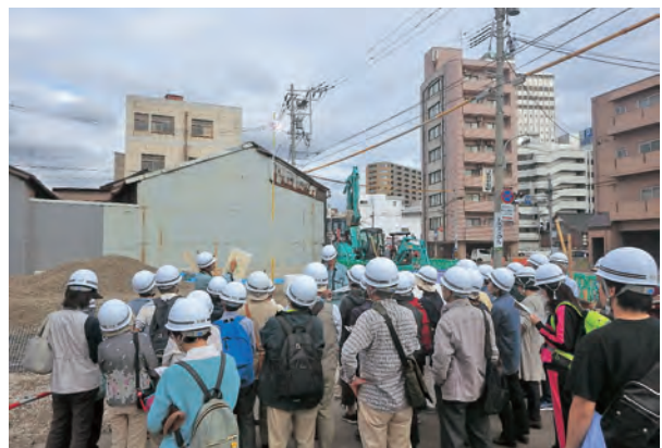
工事見学会の様子
