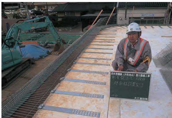
土居壁面材設置状況
