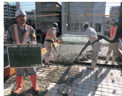
コンクリート床板施工状況
