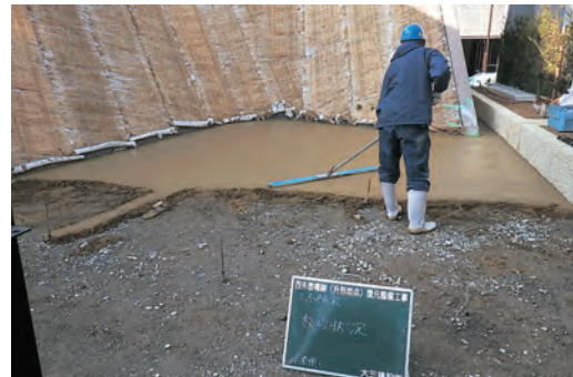
土系舗装施工状況
