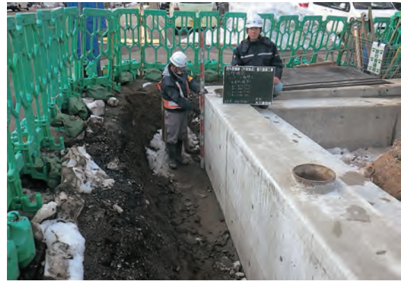
コンクリート擁壁（上流側）設置状況
