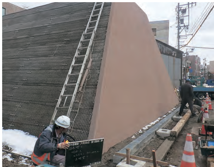
壁面吹付完了
