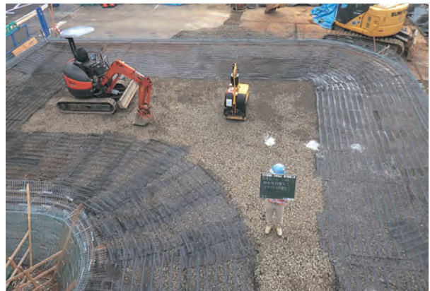
ジオグリッド工完了
