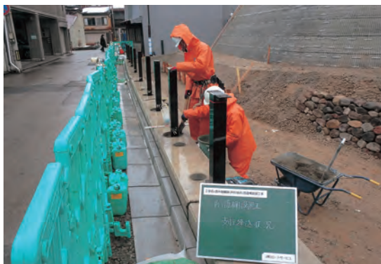
立入禁止柵施工状況
