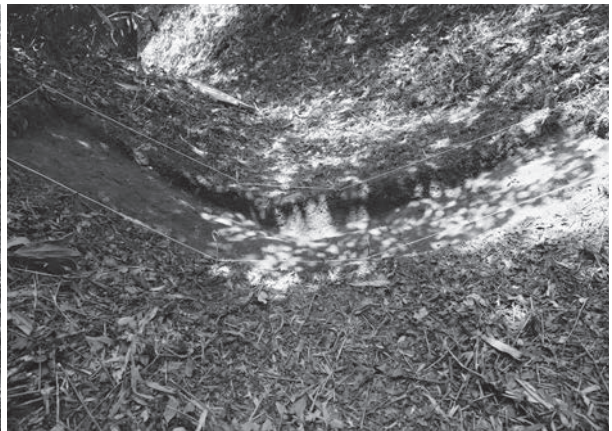
C 調査状況
