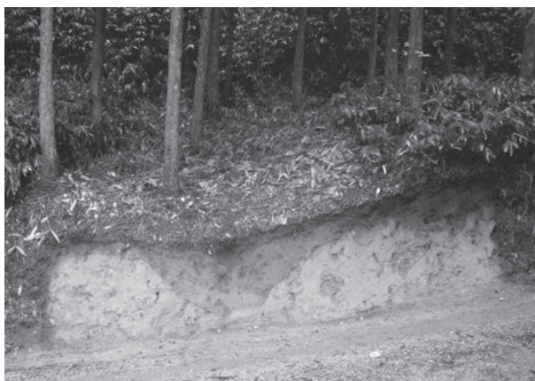
I南側 調査状況
