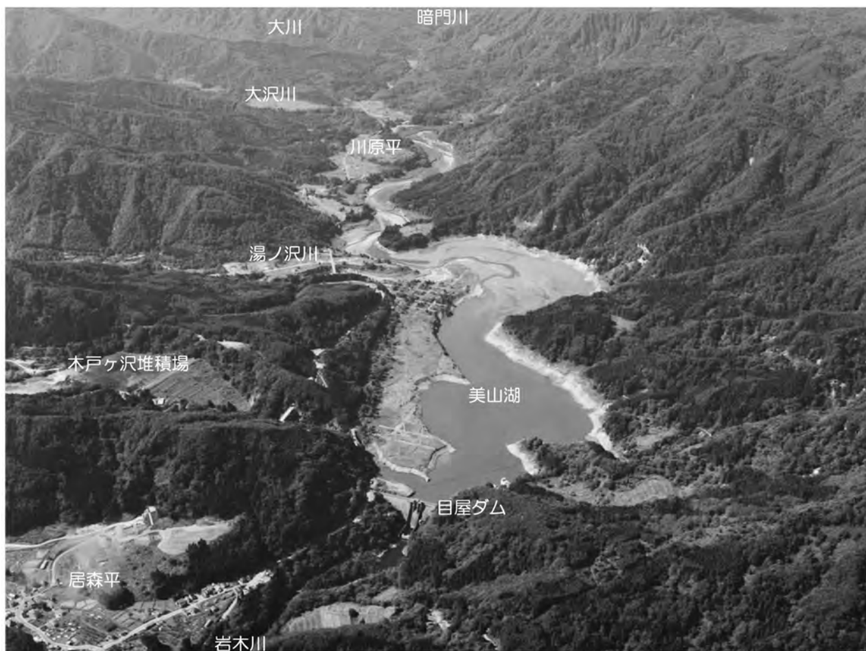
図2 津軽ダム周辺の空中写真（東から）
