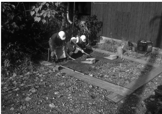
1区 表土掘削はじめ (南東から撮影)
