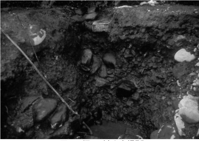
1区 石垣2 (東から撮影)
