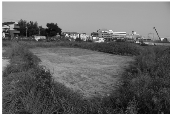
R975 埋め戻し完了状況（北西から）
