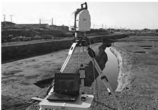
写真3 地上レーザー計測状況
