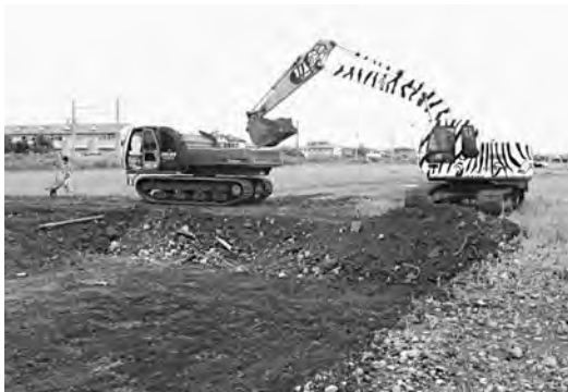
写真 1 重機による表土掘削
