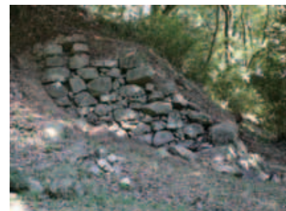
高さ3メートルに及ぶ石垣があったと考えられる箇所(西Ⅱ 東側)
