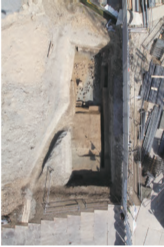
調査区全景（上が北西 H23年度B区）
