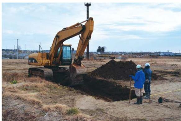
写真3 表土掘削状況
