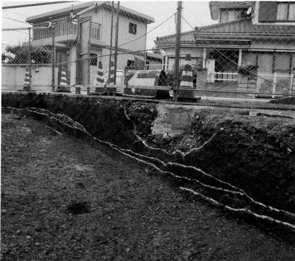
3. A区NR-1土層 (南西から)
