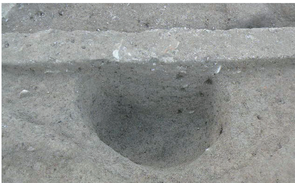
A-1SK1017 断面状況
