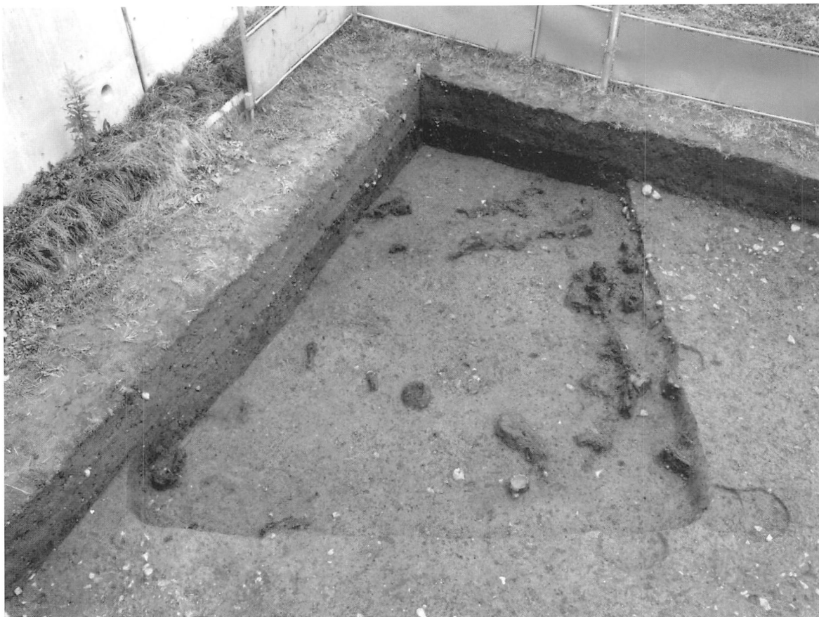
1 竪穴住居11焼失状況（北西から）
