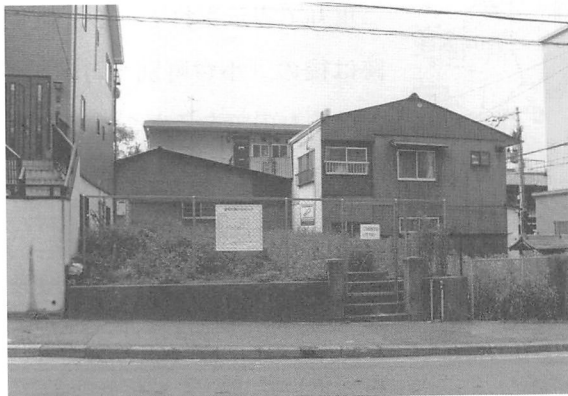
図10 調査前全景（北から）
