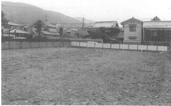
図30 調査前全景（北西から）
