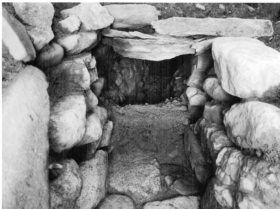
2 B区暗渠内部 (西から)
