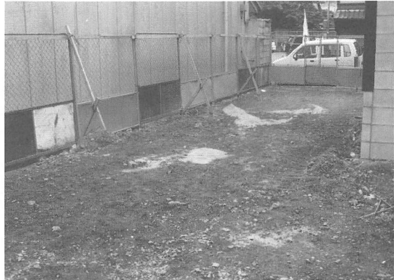
図3 調査前全景(北から)
