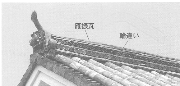
図74 雁振瓦・輪違い使用例
