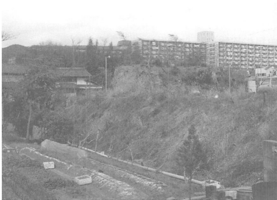
図56 調査前全景（南西から）
