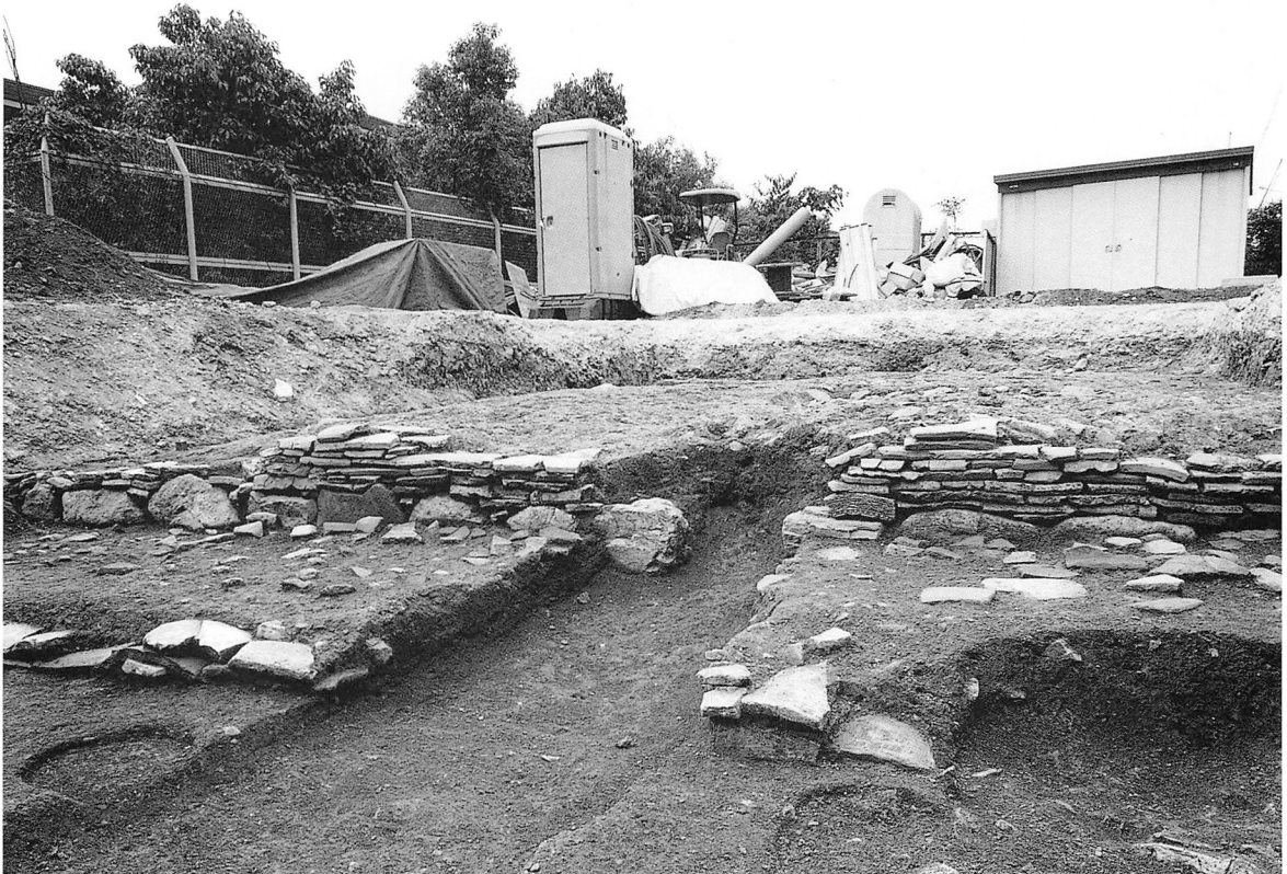
2 瓦積基壇（東北東から）
