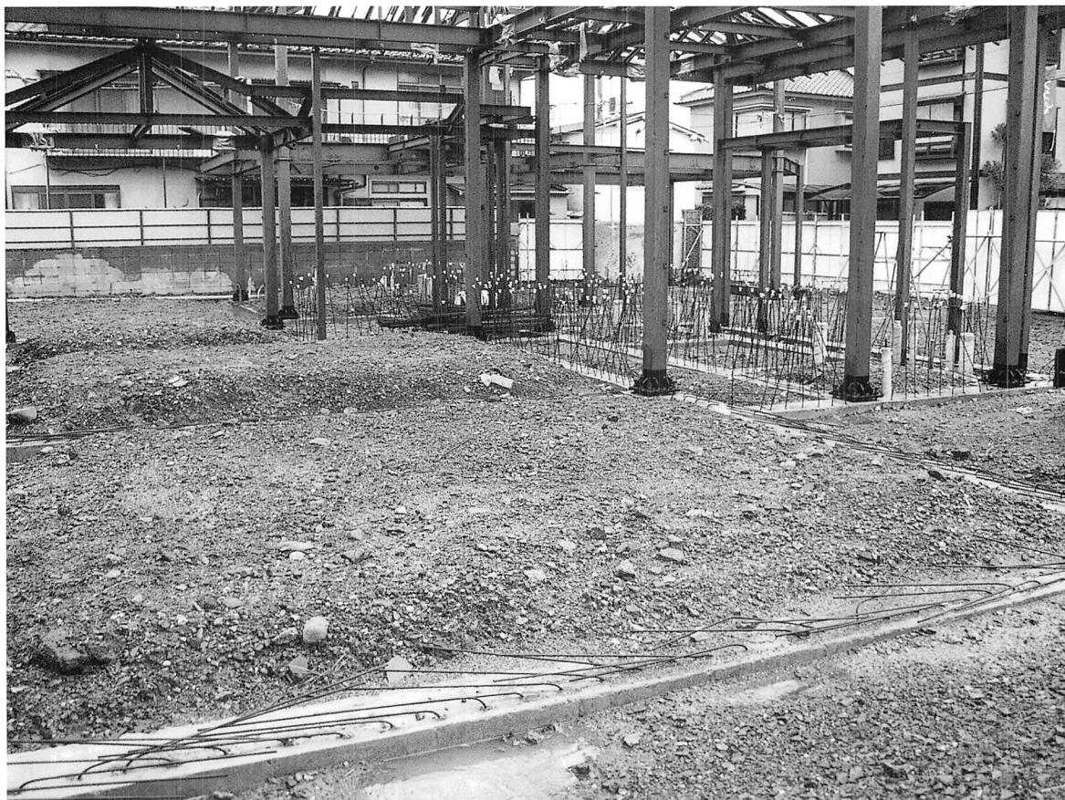
1 調査前全景（南から）
