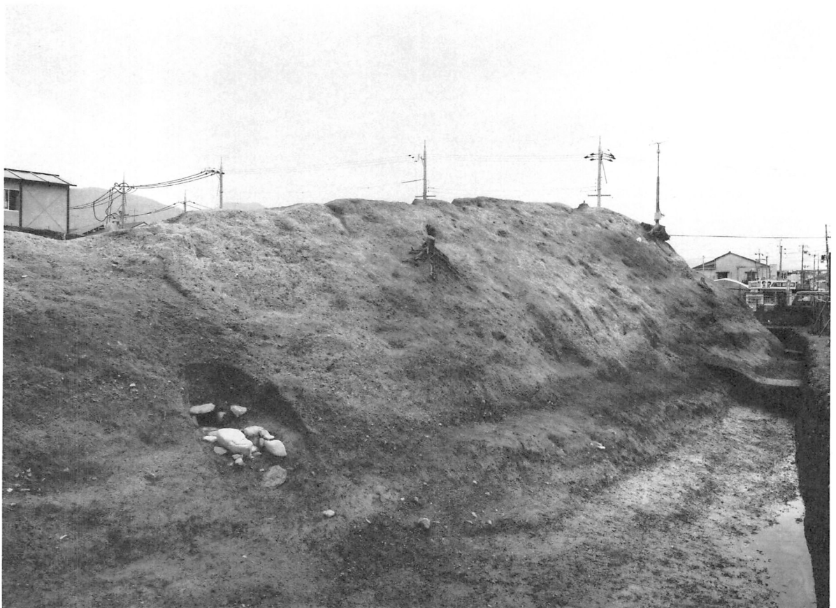
2 土塁・暗渠排水口と堀
