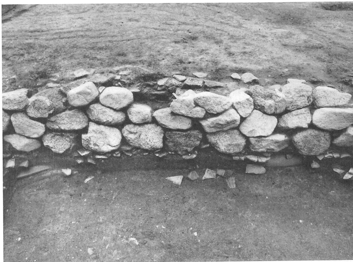
1 基壇北側 石積と瓦積（北から）
