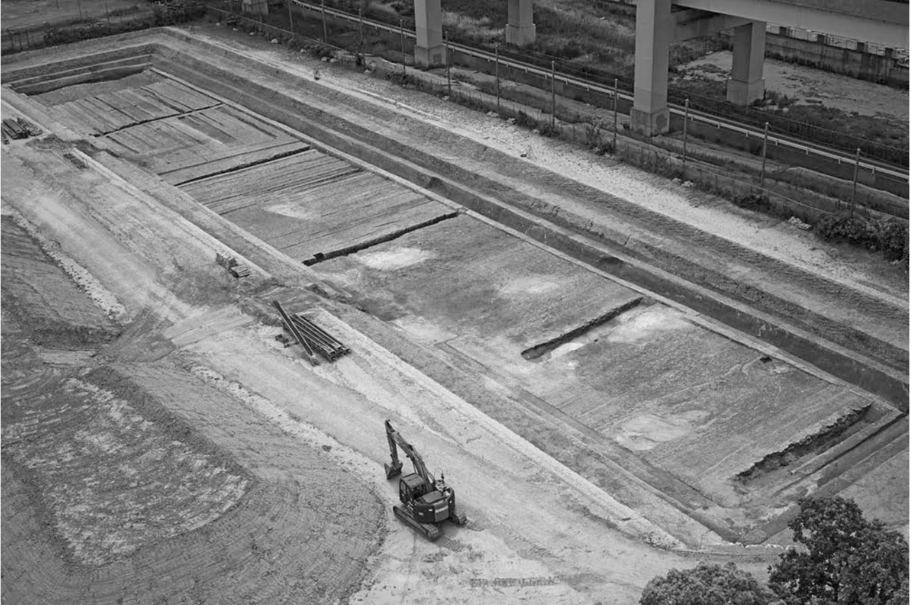
(1) 調査地(第3面)全景(北西から)
