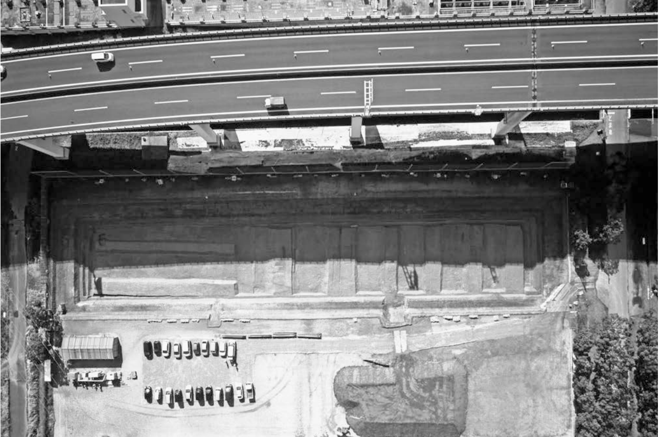
(1) 調査地(第1面)全景(上空から：下が北)
