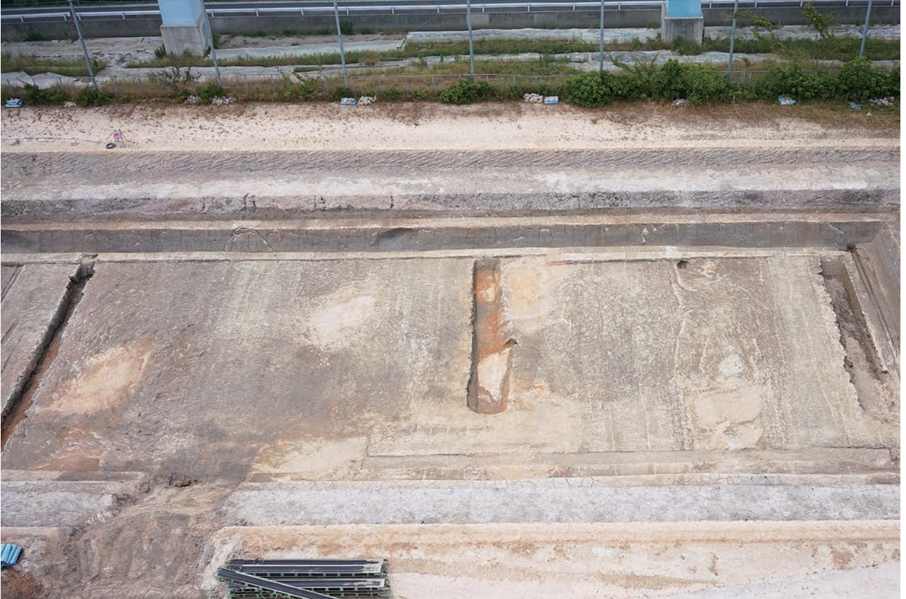
(1) 地震痕跡全景(北から)
