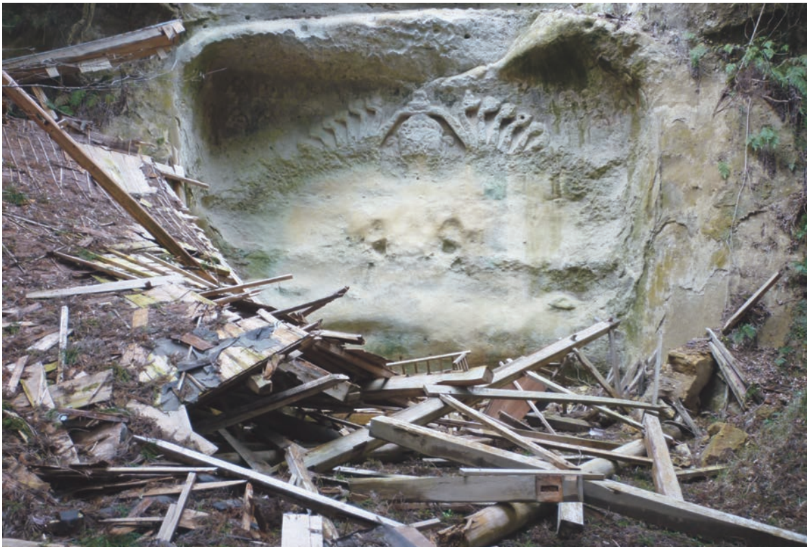
写真1 東日本大震災被害状況(1)
