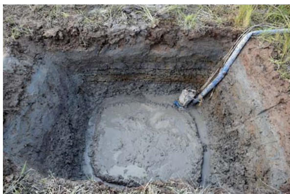
T9 完掘状況（東から）
