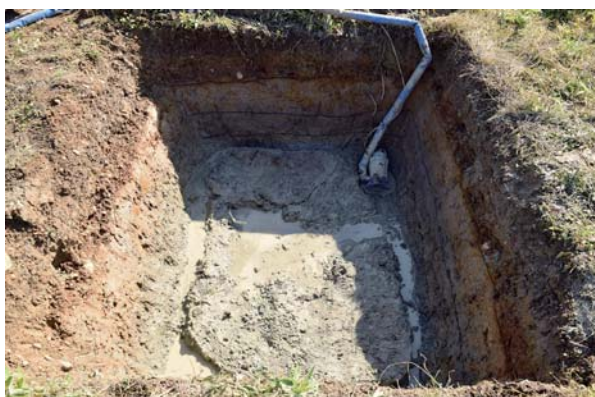
T10 完掘状況（西から）
