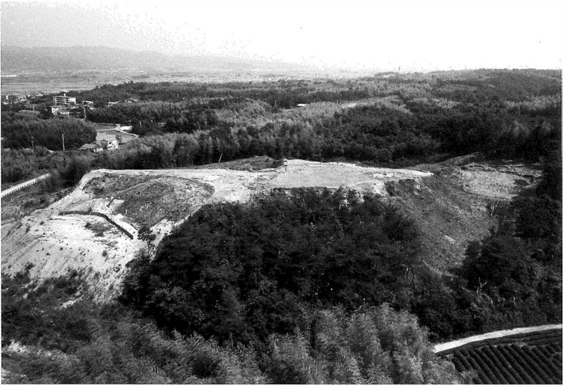
(1) 調査前全景 (北から)
