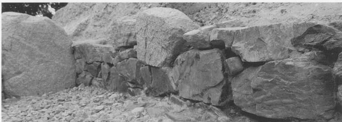
第53図 1号墳玄室左側壁（南から）
