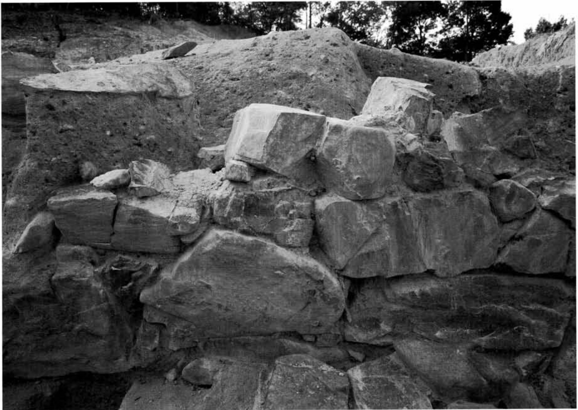
第29図 11号墳羨道部西側壁細部（北東から）
