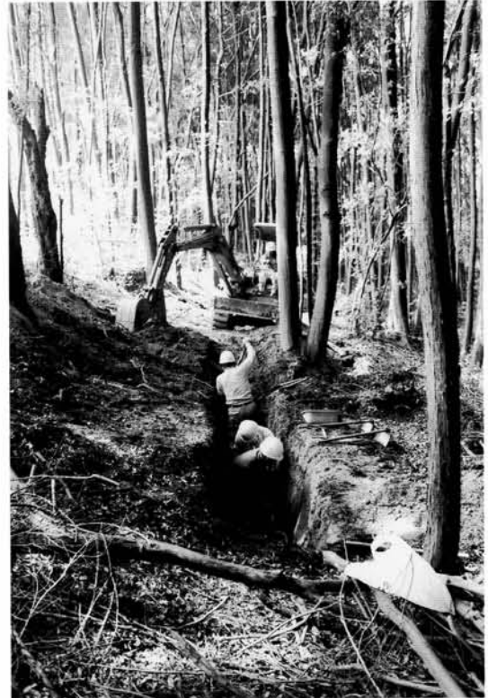
第6図 試掘調査風景（南から）
