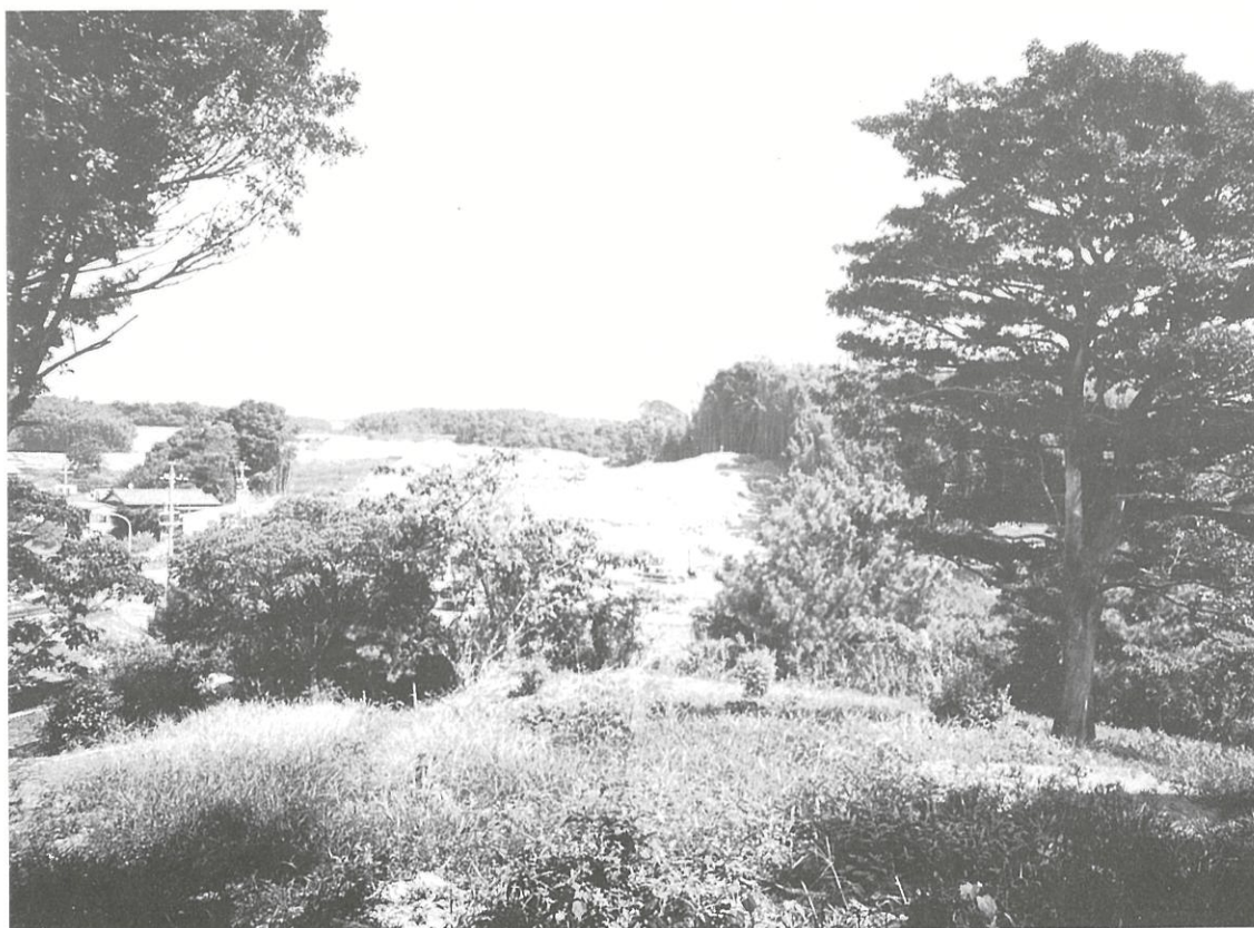
調査後遠景（西より）
